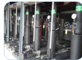
动力泵组 Power Pump
