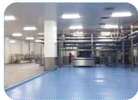
无尘车间 Clean Room
