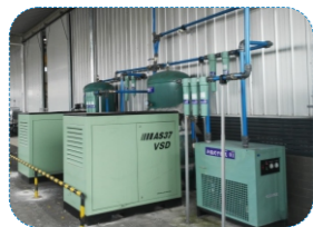
空压系统 Air Compressor System
