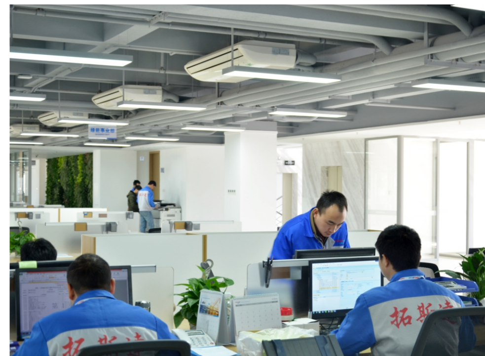
办公楼内部空调
