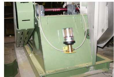
食品工业: Solyvent Ventec 通风机轴承润滑。
